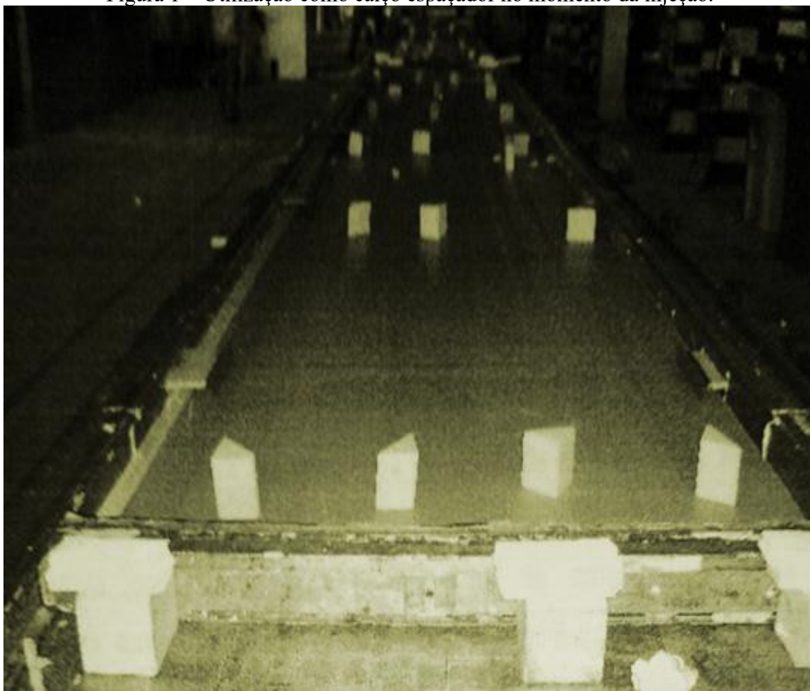
Figura 1 – Utilização como calço espaçador no momento da injeção.
