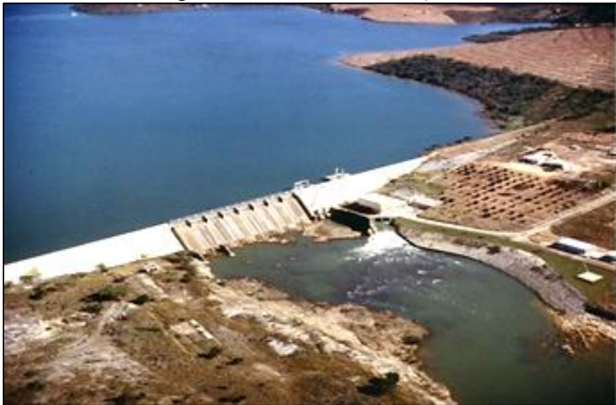
Figura 5. Usina Hidrelétrica de Cajuru.
