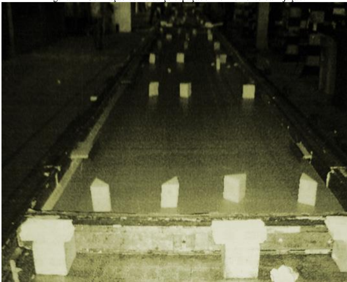
Figura 1 – Utilização como calço espaçador no momento da injeção.
