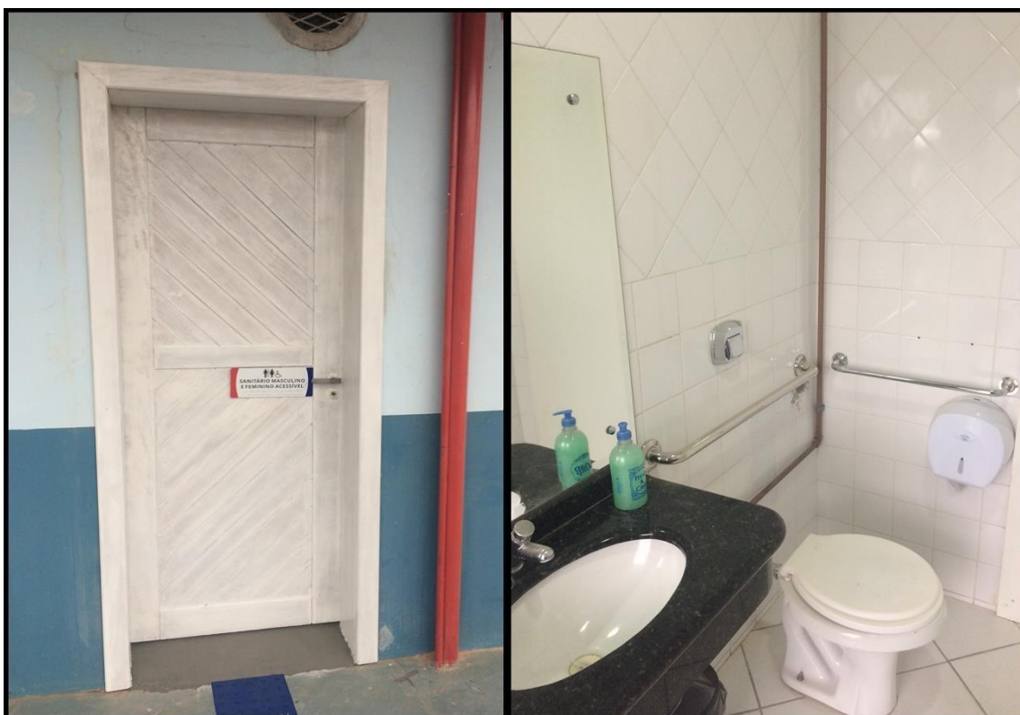
Figura 69: Vista do banheiro específicos para PNE’s no piso térreo
